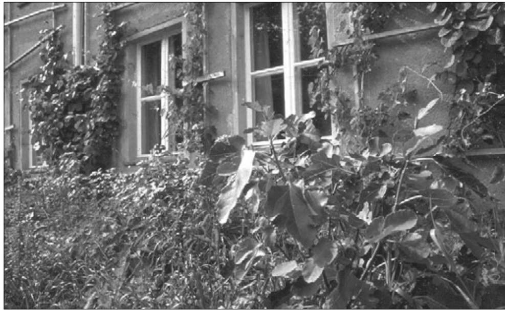
Das massive Seminargebäude im ZEGG erhielt durch rankenden Wein mehr Leichtigkeit.
