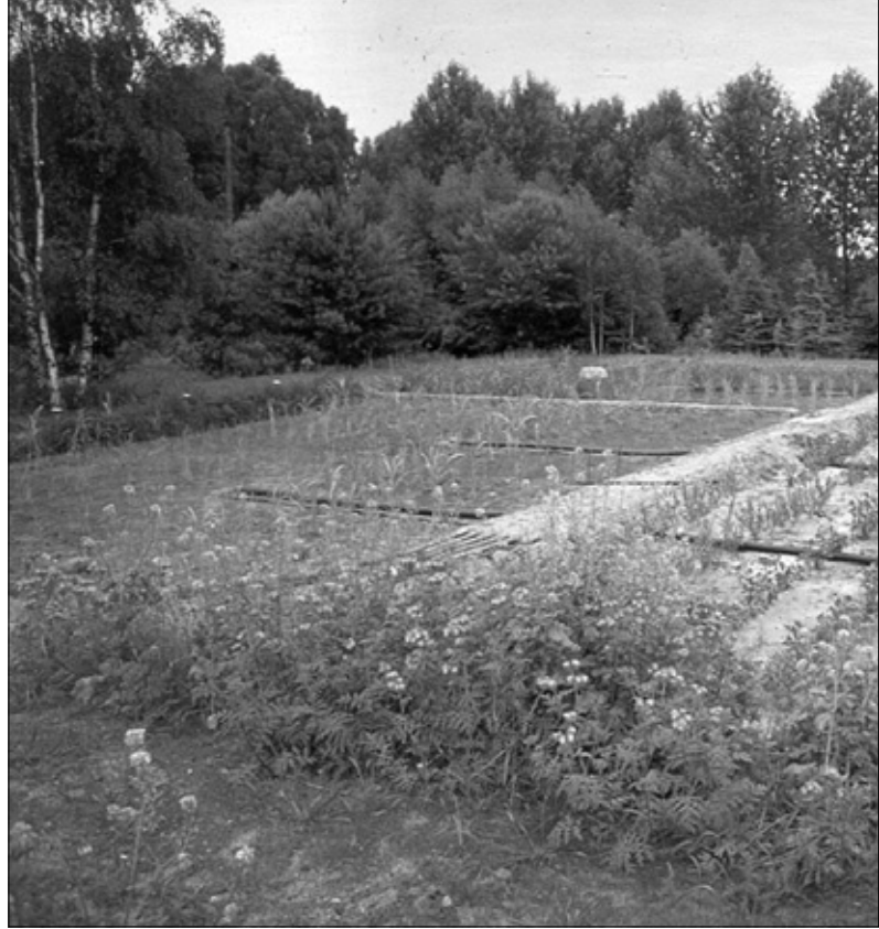
ZEGG-Kläranlage mit nachwachsenden Rohstoffen (Weiden, Pappeln)
