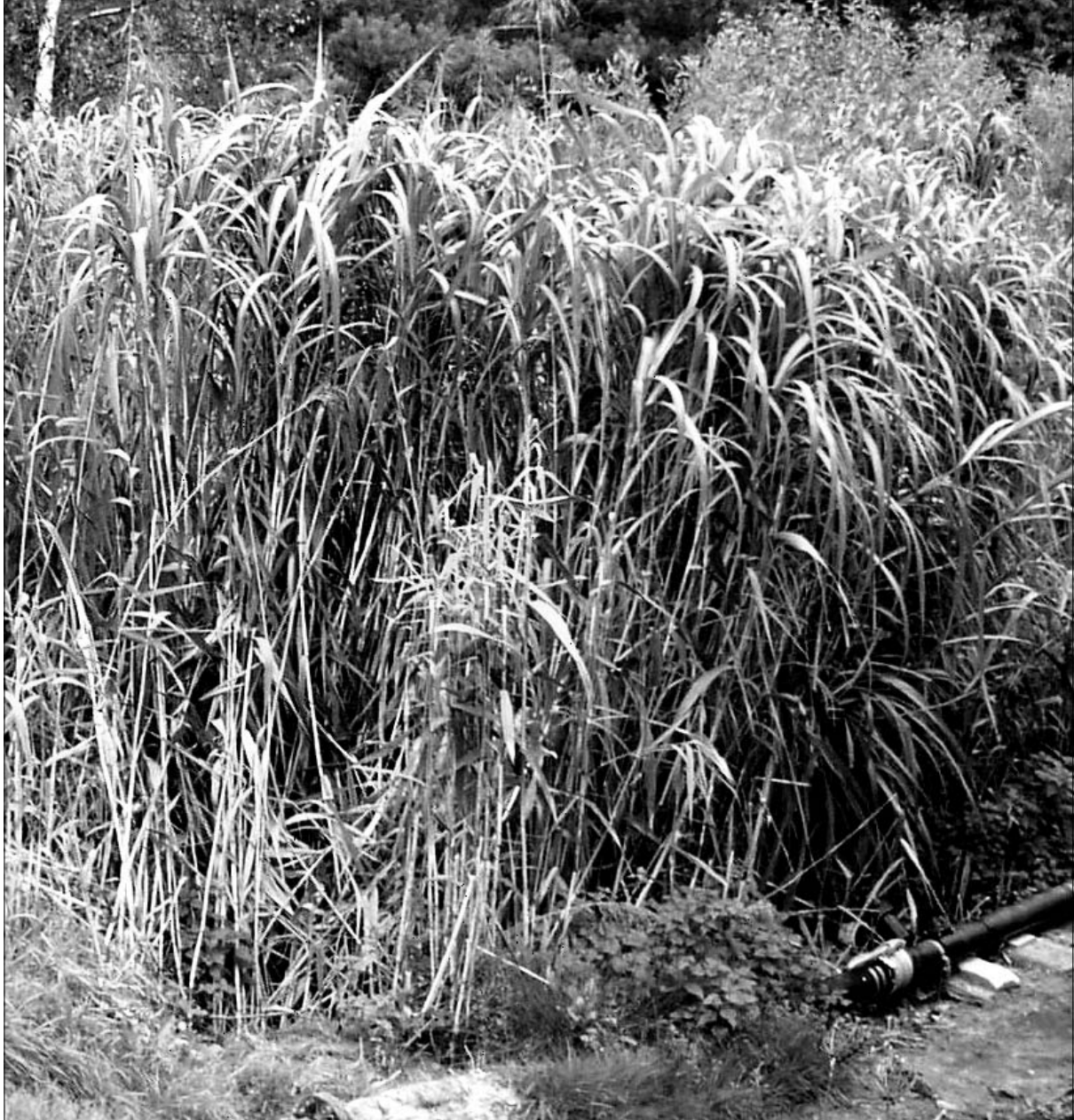
Blick ins hochgewachsene Schilf der ZEGG-Kläranlage
